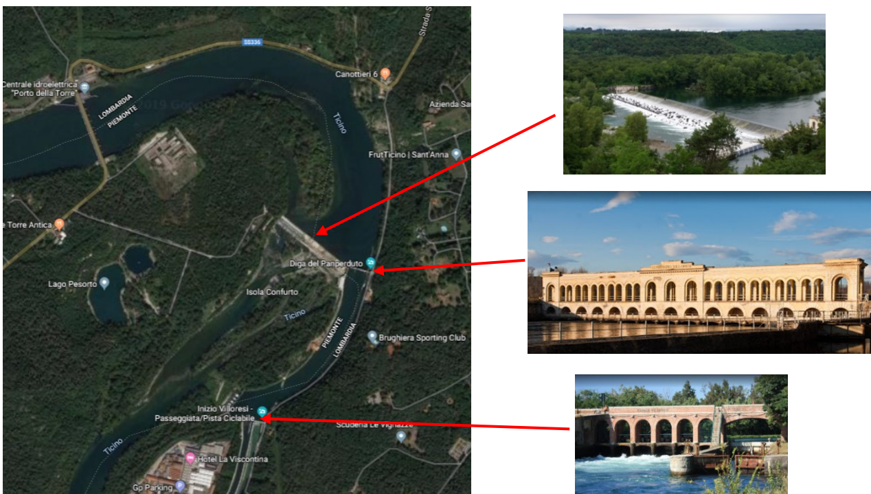
Figura 7 Il corso tortuoso del Ticino nei pressi della diga del Pan Perduto: nella foto sopra l'incile, al centro lo sbarramento di regolazione e sotto la presa per il Canale Villoresi. Recentemente è stato realizzato a lato anche un Canale Industriale per alimentare varie centrali elettriche.
